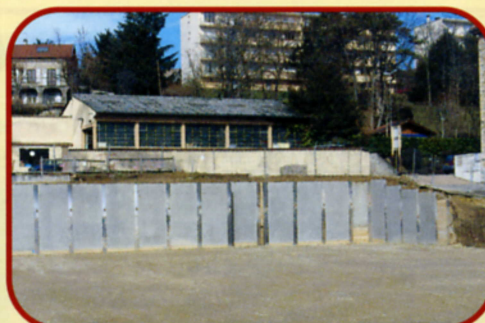
Terrassement bâtiment à construire
